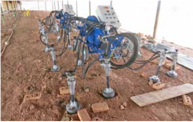
»3a and 3b Burners with oil-fuelled operation »3a und 3b Brenneranlagen mit Ölbetrieb
